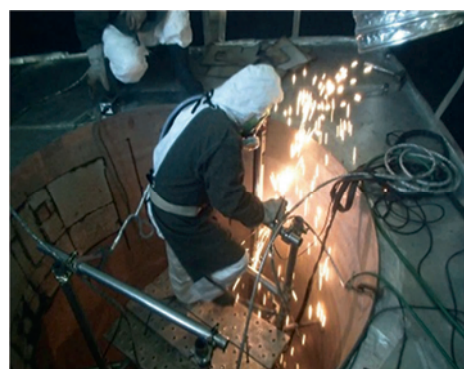
排水槽内での溶断風景
