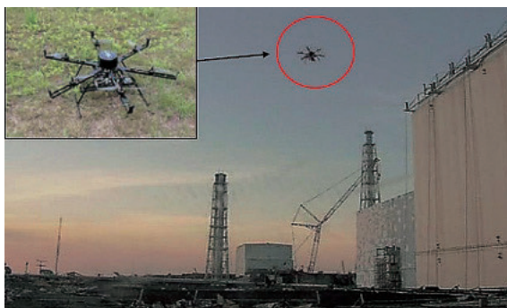
ドローンによる福島第一タービン建屋屋根の線量調査 廃炉・汚染水対策チーム会合事務局会議（第13回 平成26年12月25日） 【資料3-3】環境線量低減対策より（東京電力(株) 殿ホームページより）
