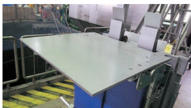
写真5 天井遮蔽板の外観
