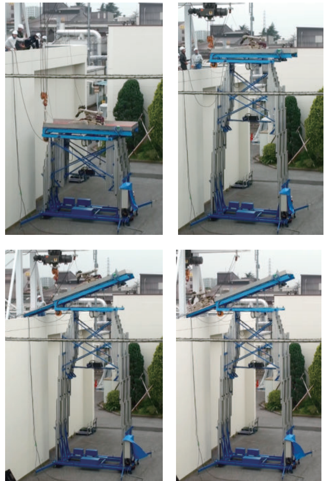
写真3 確認試験の様子
