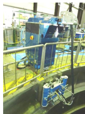
壁面除染装置の動作試験
