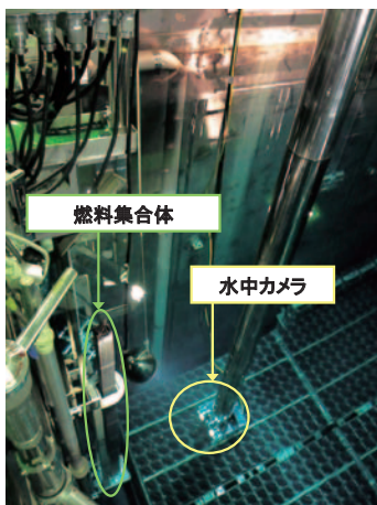
写真1 外観検査の実施状況 1), 2)
