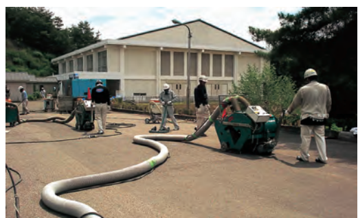
写真1 アスファルト舗装表層の汚染除去作業
