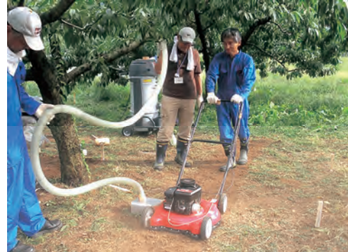
写真3 果樹園の表土剥離作業
